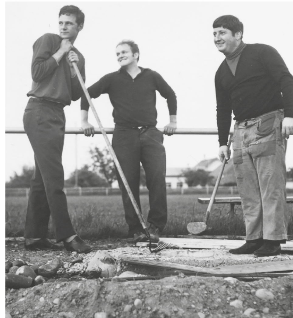
1970, Errichtung der Flutlichtanlage. Kurt Ackermann, Peter Moser, Paul Mäder (von links) sorgen für ein solides Fundament der Masten.
