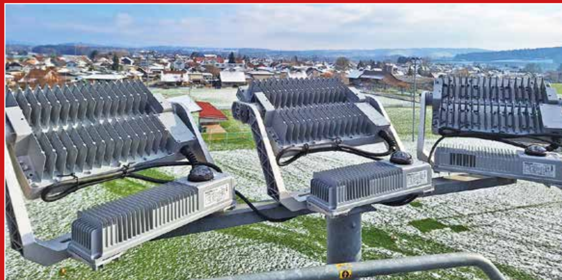
Die bestehenden Masten sind nun mit LED-Strahlern ausgerüstet.
