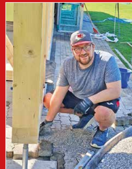
Auch auf dem Bau ein sicherer Wert: Lukas Rickli.
